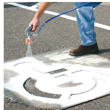
Нанесение разметки с помощью трафарета
